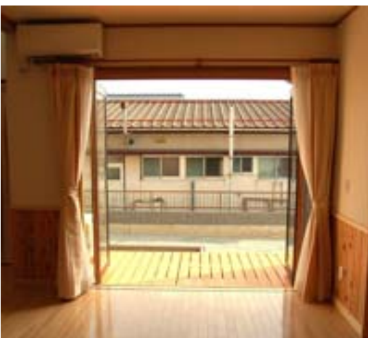
▲【LDK～ウッドデッキ】リビングとフラットに施工したので天気の良い日など開放し広々とした空間に広がります。
